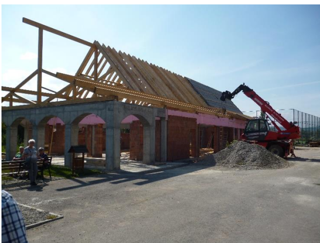
foto 8: sporthal in aanbouw
